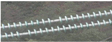
图1 自爆绝缘子图
