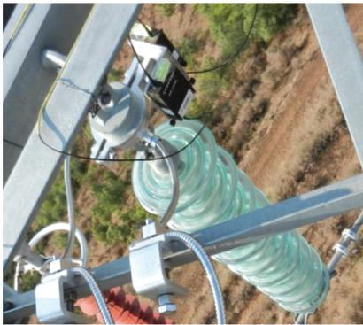
图 11 绝缘子风偏角传感器现场施工图
