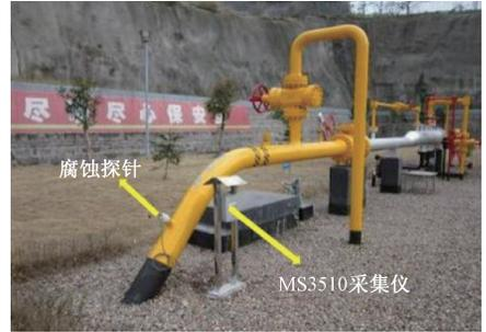
图6 天然气管道腐蚀监测现场
