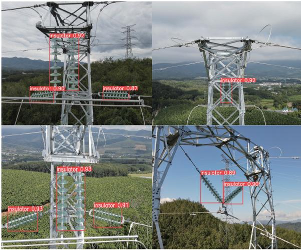
图 13 真实数据集部分绝缘子检测结果
