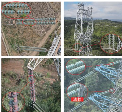
图 1 绝缘子自爆巡检图像案例
