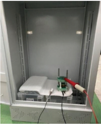
图 4 开关柜局部放电检测实验
