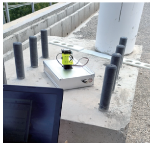
图 1 接触网支柱基础螺栓图像采集设备
