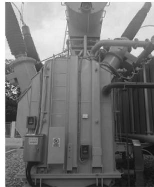
图 3 220 KV 油浸式变压器
