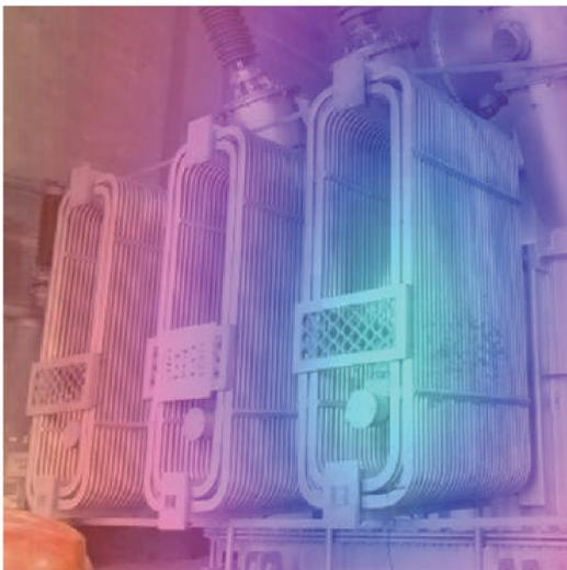
图2 室内变压器噪声定位结果
