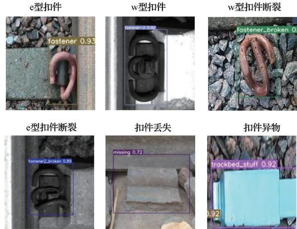
图8 轨道扣件状态示例
