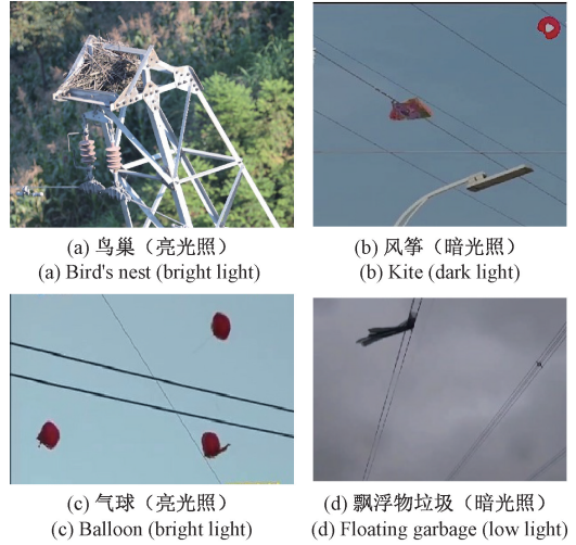
图 15 输电线路异物数据集示例
